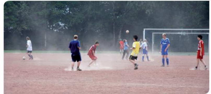
Abb. 70: Staubentwicklung durch Trockenheit und Entmischung der Deckschicht
